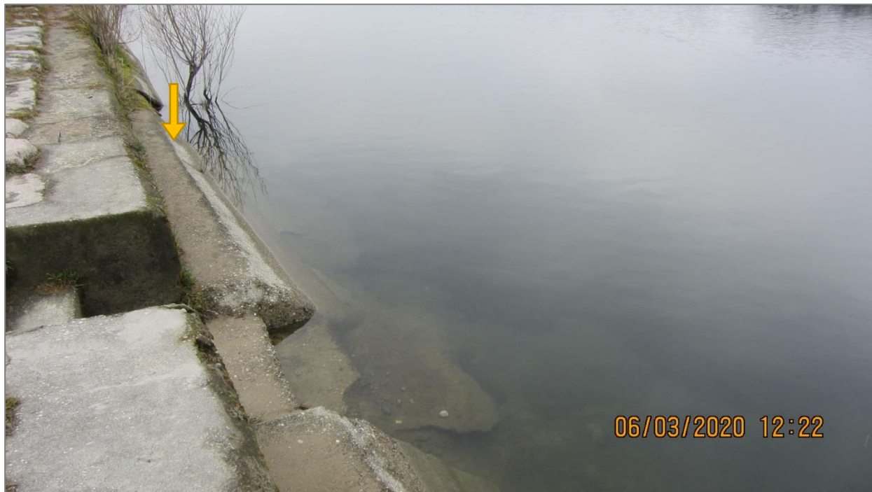
Figura 15: Sito di installazione proposto per la stazione Oleggio, vista da monte
