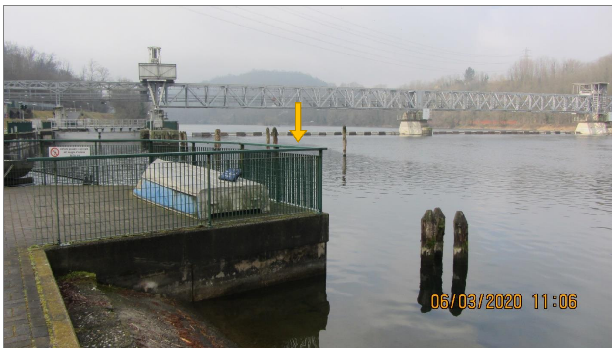
Figura 6: Vista da monte del sito di installazione della stazione Miorina
