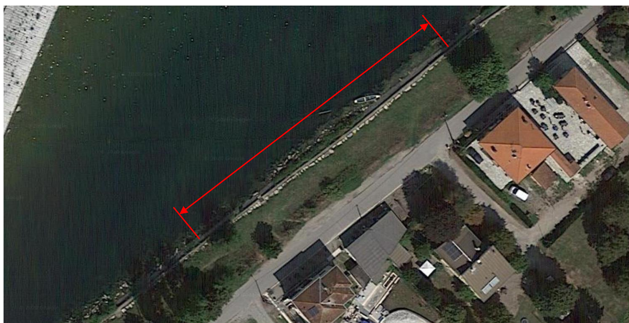
Figura 12: Tratto caratterizzato da stesso tipo di sponda
