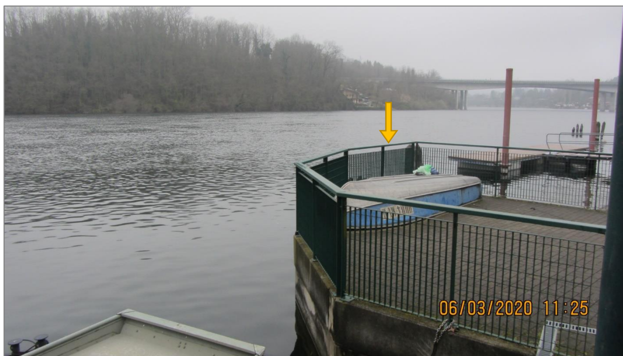
Figura 9: Vista da valle del sito di installazione della stazione Miorina
