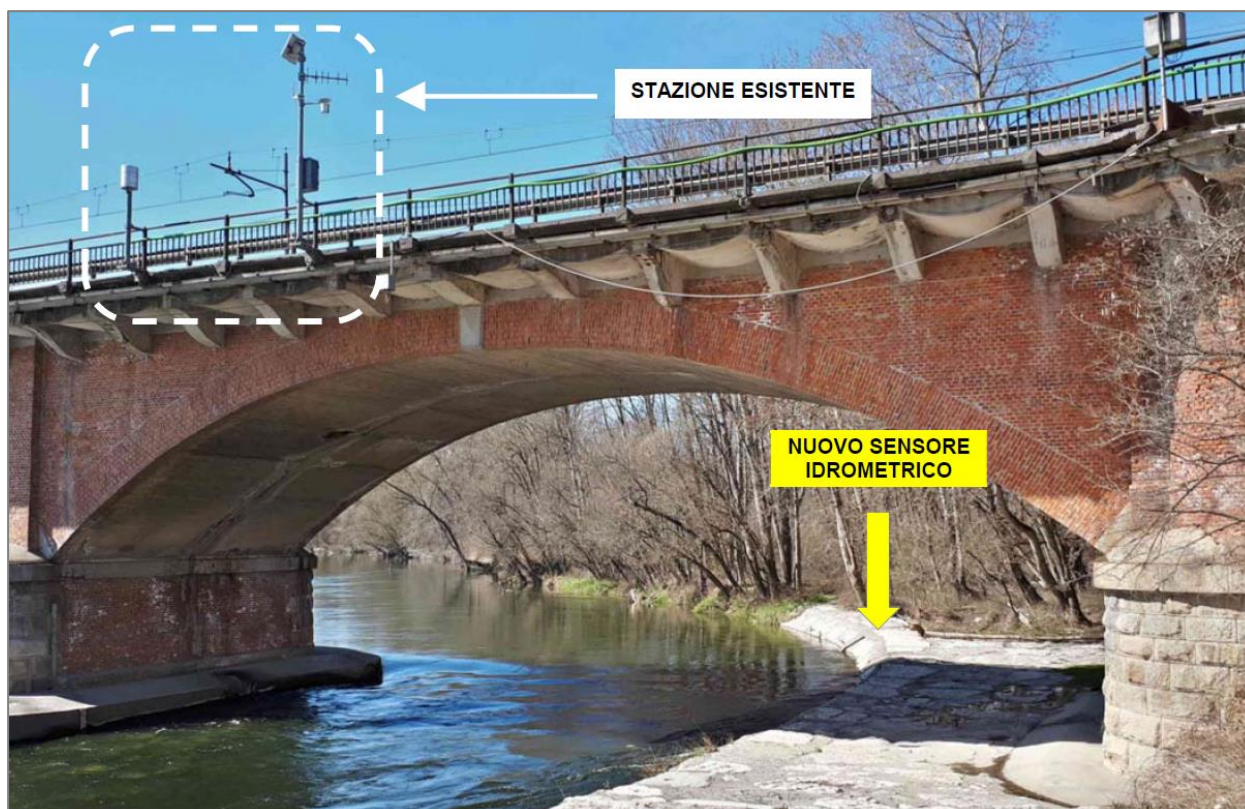
Figura 22: Vista da valle del ponte della sponda sinistra dove è installato il nuovo misuratore di livello di ARPA, in prossimità del quale è prevista la stazione di monitoraggio qualitativo. Sul ponte la stazione di misura di livello ARPA esistente.
